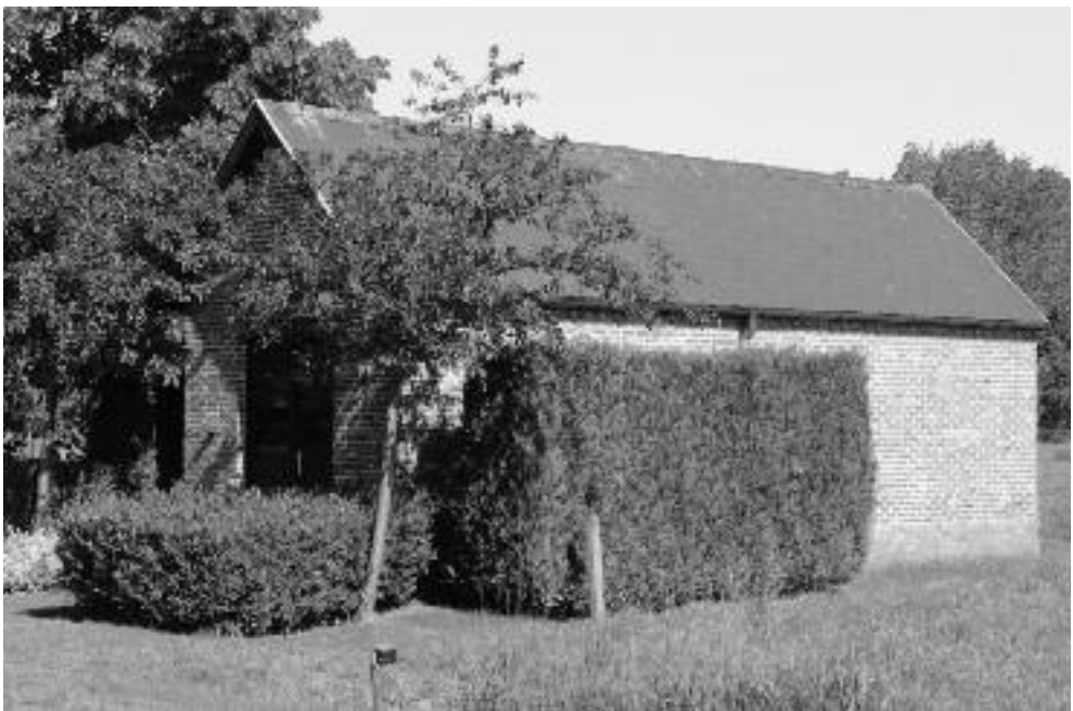
De kapel anno 2011 met in het laatste gedeelte een elektriciteitscabine.
